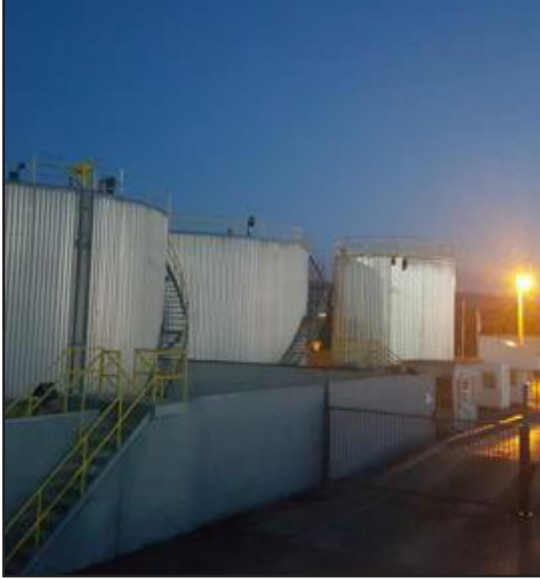
Şekil 7. Yerüstü Tankı Taşma Havuzu Örneği
