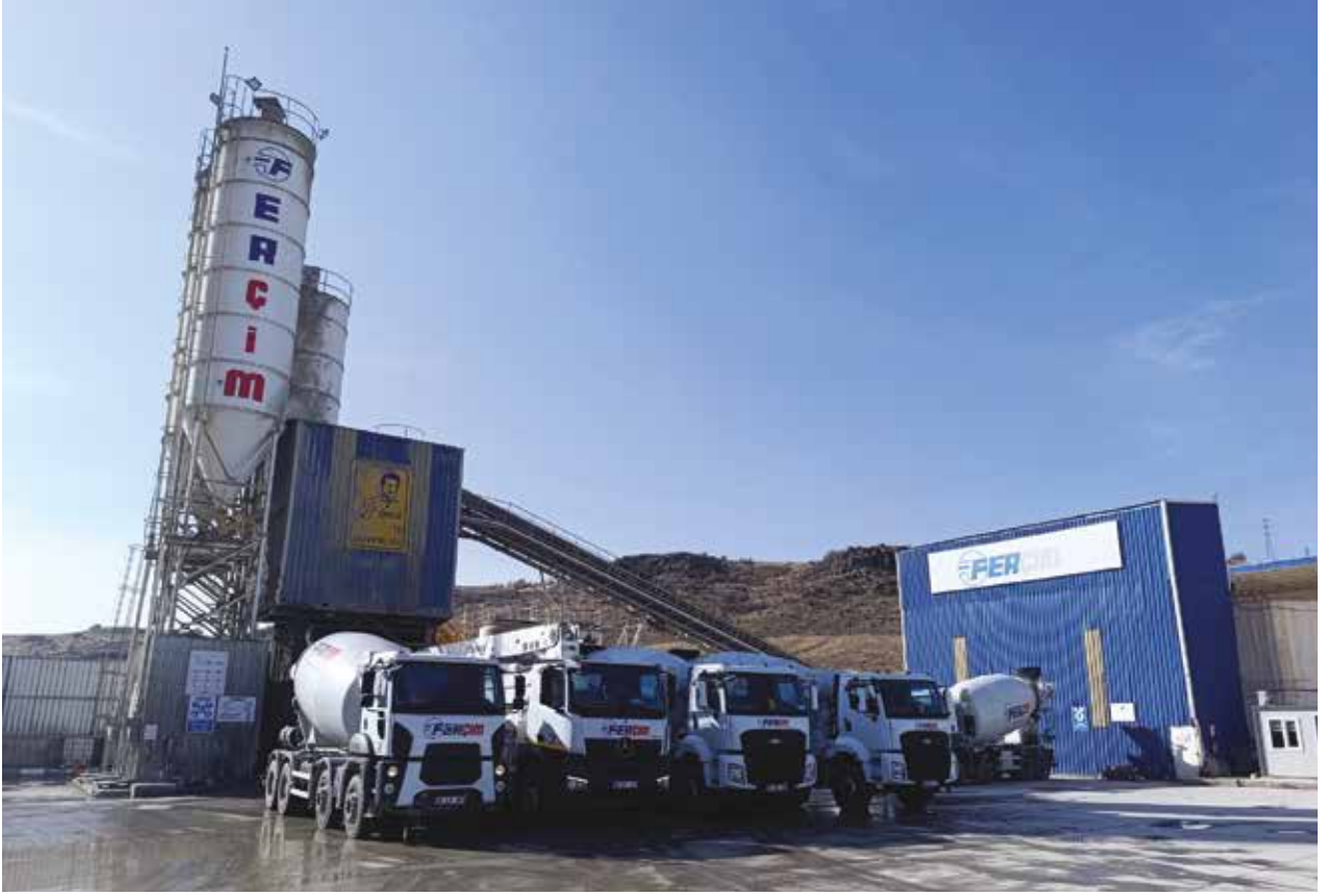
Ferçim Nevşehir Hazır Beton Tesisi
