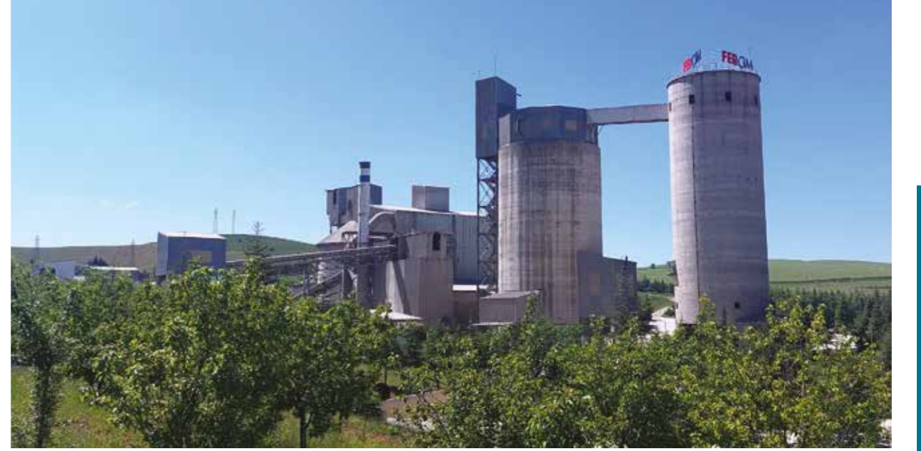
Ferçim Ankara Çimento Fabrikası
