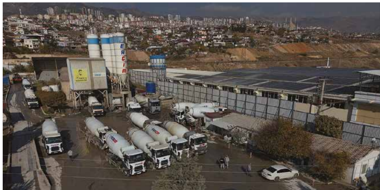
Ferçim Kahramanmaraş Hazır Beton Tesisi
