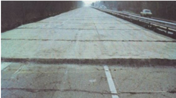
ŞEKİL 24 – BETON DÜZELTME TABAKASI
