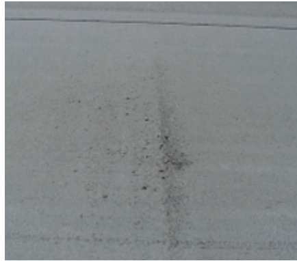
ŞEKİL 6 – YOL YÜZEYİNDE MALZEME KAYIPLARI
