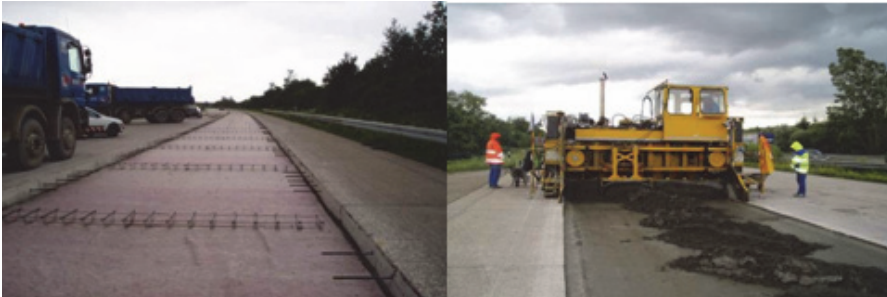
ŞEKİL 16 – ŞERİT YENİLEME: HAZIRLIK VE UYGULAMA
