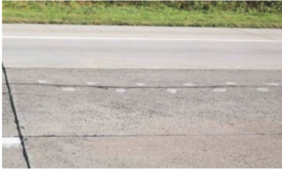
ŞEKİL 32 – RETROSPEKTİF ÇAPRAZ ANKRAJ
