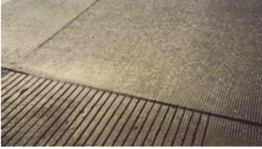
ŞEKİL 15 – KANALLI FREZELEME
