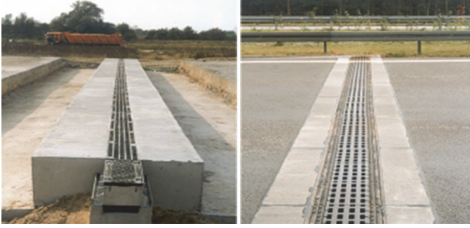
ŞEKİL 25 – KUTU KANALLARIN YERLEŞTİRİLMESİ
