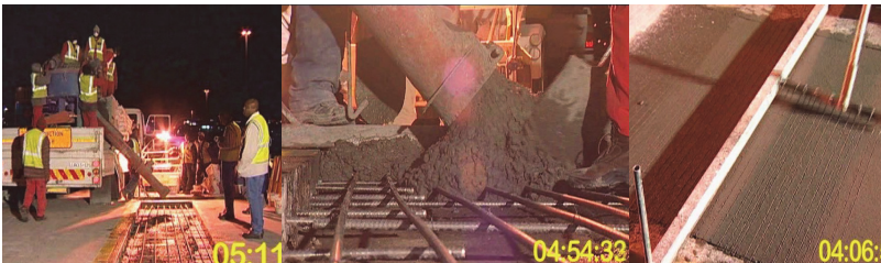
ŞEKİL 2 – BETONUN DÖKÜLMESİ, YERLEŞTİRİLMESİ VE YÜZEY BİTİRME İŞLEMLERİ
