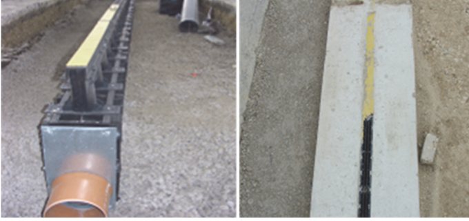
ŞEKİL 26 – TAŞMA KANALLARIN YERLEŞTİRİLMESİ
