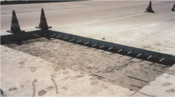
ŞEKİL 35 – PLAĞIN BİR KISMININ ANKRAJ YAPILARAK YENİLENMESİ
