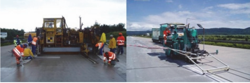
ŞEKİL 17 – ŞERİT YENİLEME: BETON VE FREZELENMİŞ KANALLARIN DÜZENLENMESİ
