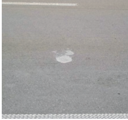
ŞEKİL 4 – PÇ HARCİ İLE ONARILMIŞ SÖKÜLME
