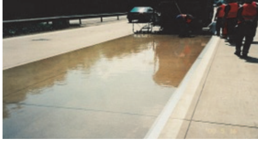
ŞEKİL 21 – MAKİNE İLE REAKTİF REÇİNE UYGULAMASI
