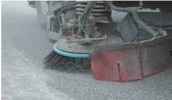
ŞEKİL 23 – FAZLA AGREGANIN SÜPÜRÜLMESİ
