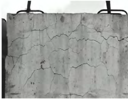
Şekil 5. Bir konutun beton temelinde sülfat tuzları içeren çiçeklenme [36]
