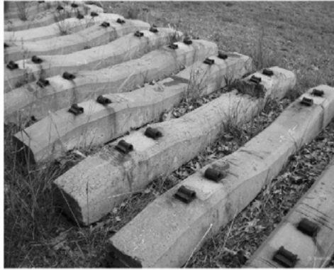
Şekil 3. Hasarlı ve hasarsız demiryolu traversleri [36]
