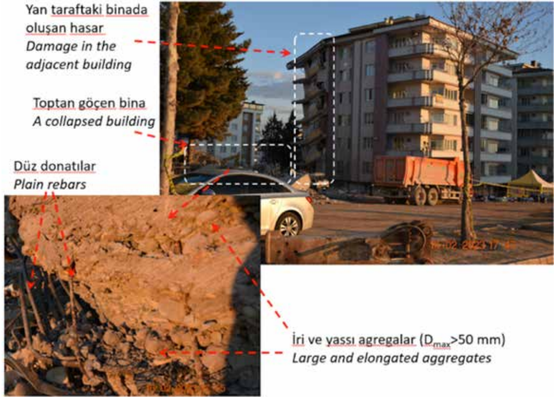
Şekil 5: Gaziantep'te toptan göçen bir bina Figure 5: A totally collapsed building in Gaziantep
