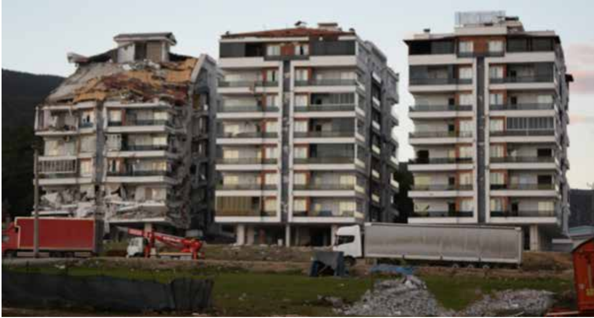
Şekil 7: Nurdağı'nda kısmi göçen ve hasar gören yeni bir site Figure 7: A partially collapsed and damaged new apartment complex in Nurdağı
