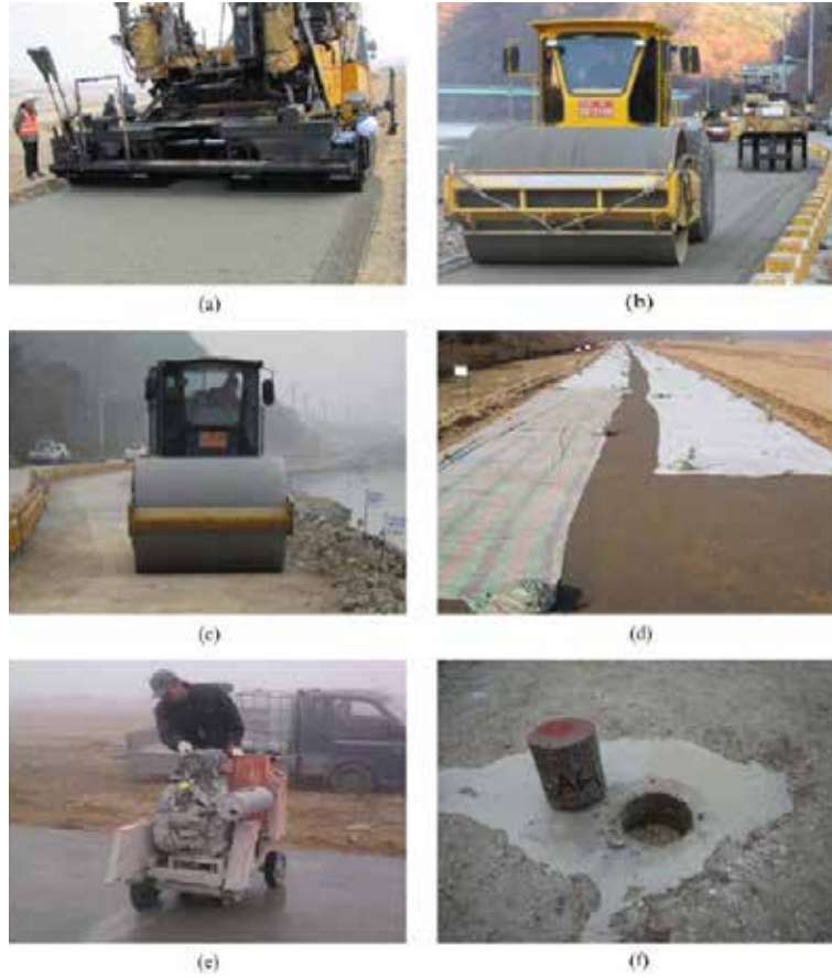
Şekil 11. SSB yol gerçek saha uygulaması (a) serilmesi, (b) titreşimli silindir uygulaması, (c) çelik tamburlu silindir uygulaması, (d) kür uygulaması, (e) derz açımı, (f) silindir karot çıkartımı
