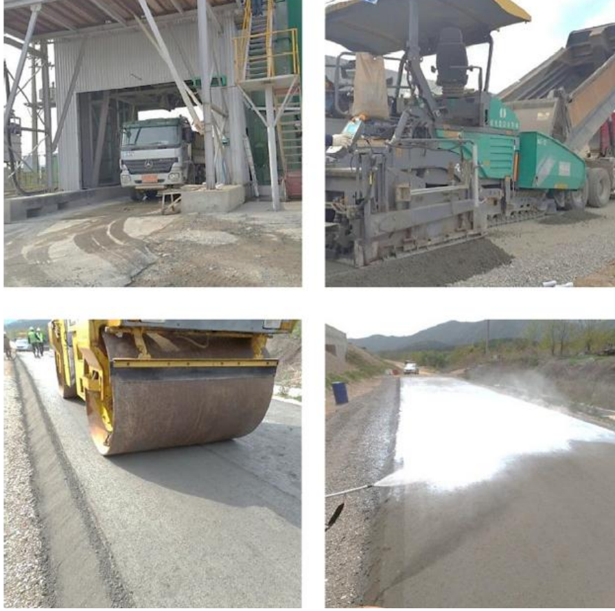
Şekil 14.SSB yol uygulaması Figure 14. RCC pavement application [21].
