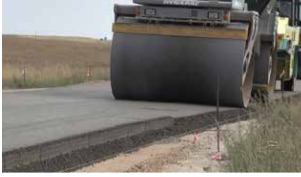
Fotoğraf 9- Silindirle sıkıştırılmış beton teknolojisi kullanılarak yerel yönetim yolu inşaatı
