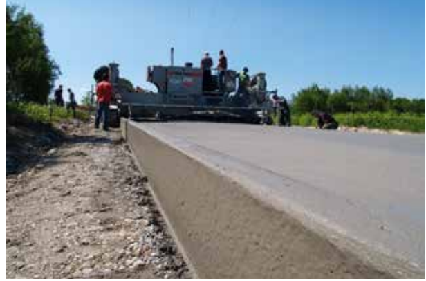
Fotoğraf 8 – Kayar kalıp kullanılarak yerel yönetim yolu inşası ve beton finişeri.
