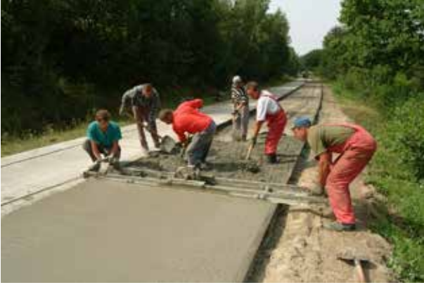
Fotoğraf 7- Vibratörlü master kullanılarak yerel yönetim yol inşaatı
