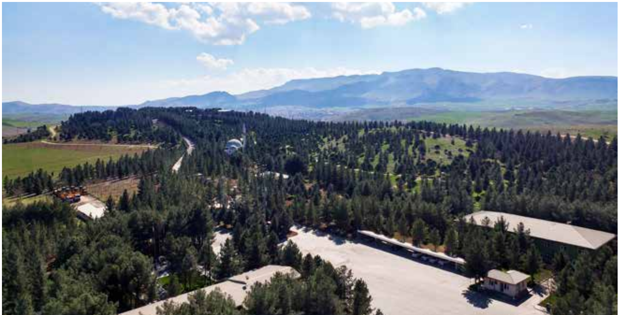
Fabrika Sahası İçerisinde Ağaçlandırılmış Alanlar / Afforested Areas in Factory Area
